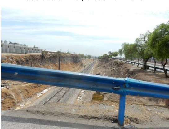
Paso sobre nivel, cruce Lo Errázuriz
